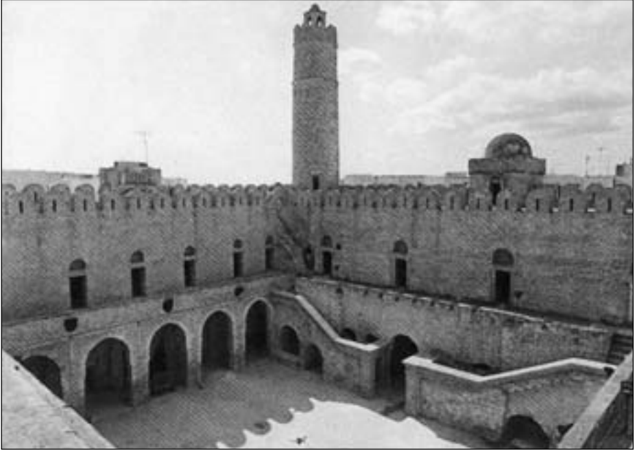
b. Cour intérieure montrant les deux étages d'aménagement ; la petite coupole surmonte l'entrée monumentale.
