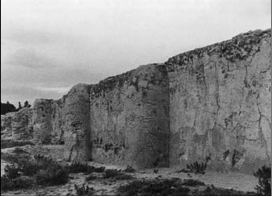
10.5. Le grand bassin de Raḳḳāda, près de Ḳayrawān ; les énormes contreforts brisaient les vagues provoquées par le vent.
